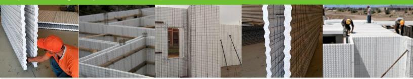
EL panel doble estructural (PCSS) se instala con sistema de amarre manual con alambre dulce y accesorios de conexión.
