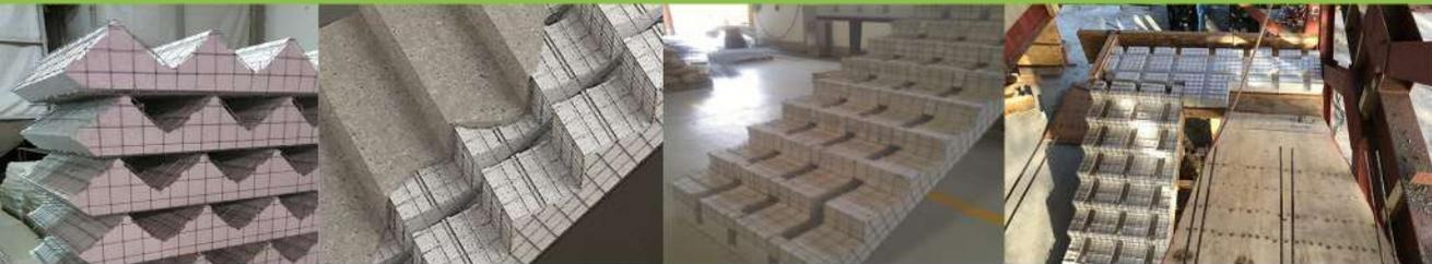
**El panel para escalera y descanso** se instala con sistema de amarre manual con alambre dulce y accesorios de conexión.
